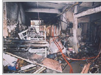
ภาพความเสียหายของการระเบิดของท่อ ออกซิเจนเนื่องจากไม่มีการติดตั้งอุปกรณ์ ป้องกันไฟย้อนกลับ
